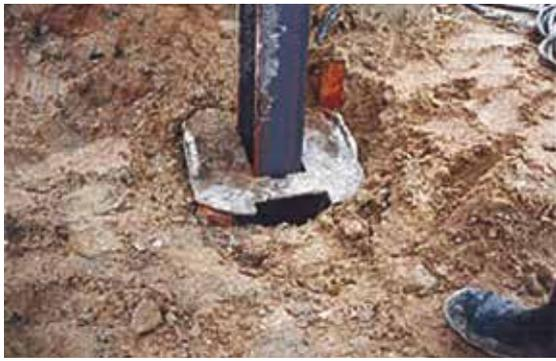
Während der Geräteführer bereits mit dem Bohren des nächsten Pfahls beginnt, wird unter Zuhilfenahme einer Schablone die erforderliche Bewehrung in den frisch betonierten Pfahl eingelassen.
