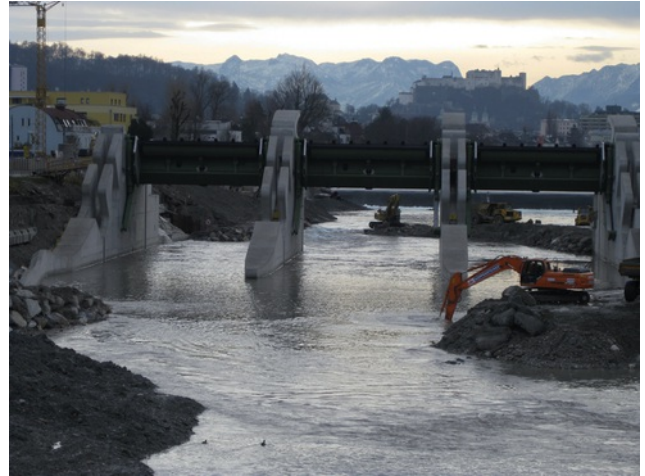
Salzachumleitung Bauphase 2 Bild: PORR
