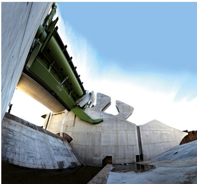
Wehrfeld Bild: PORR
