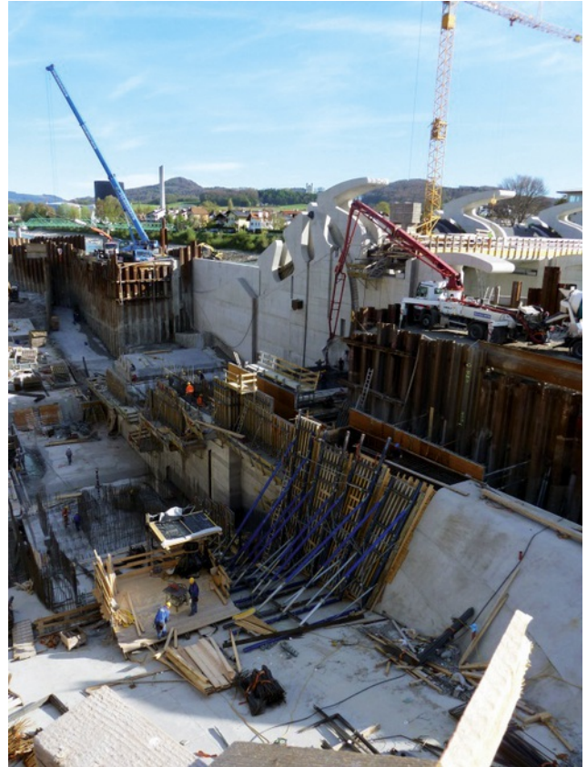
Bauphase 2 – WF1, April 2012 Bild: PORR
