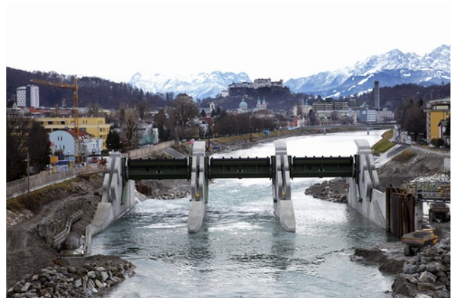
Salzachumleitung Bauphase 2 Bild: PORR
