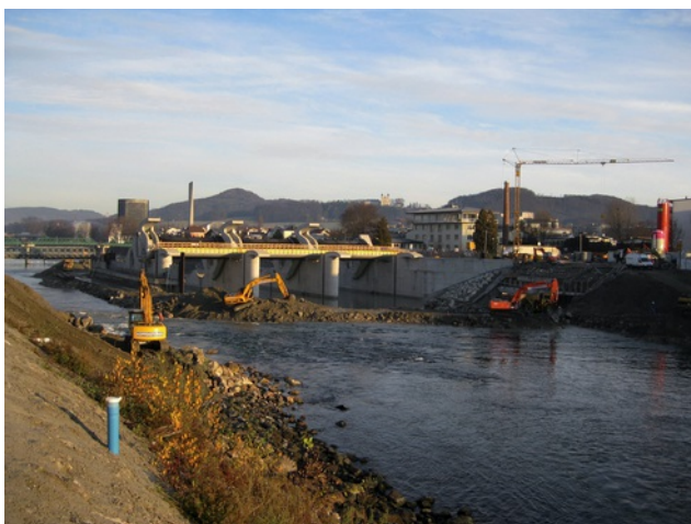
Salzachumleitung Bauphase 2 Bild: PORR
