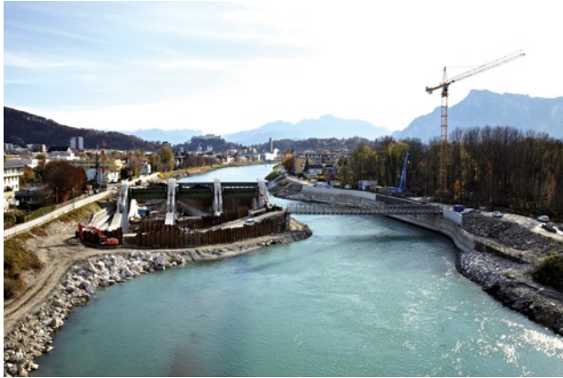
Bauphase 1 Bild: PORR
