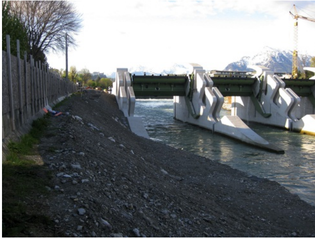
Bauphase 1 – Wehrfeld 2-4, April 2012 Bild: PORR
