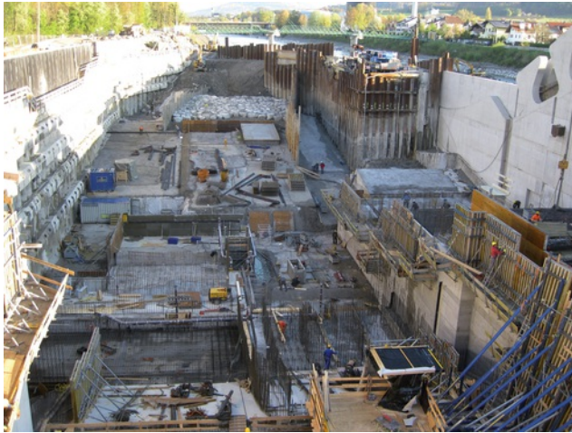
Bauphase 2 – Krafthaus Bild: PORR
